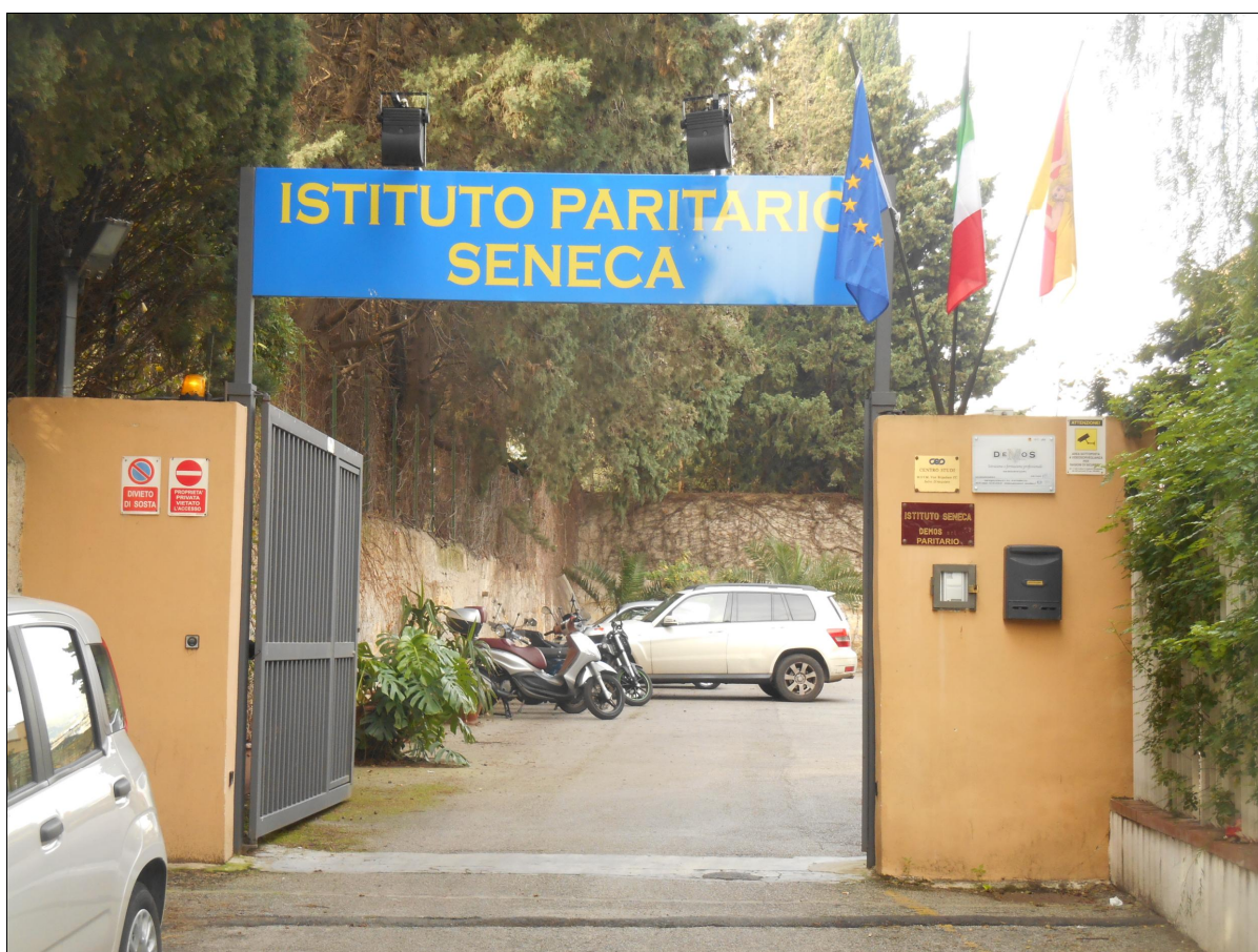
Via Paisiello all'altezza del 2° cancello
