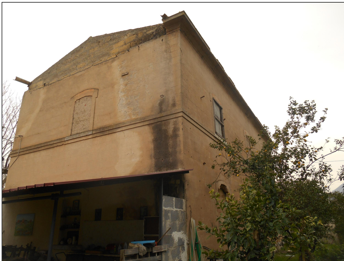
Stazione Uditore. Vista angolare
