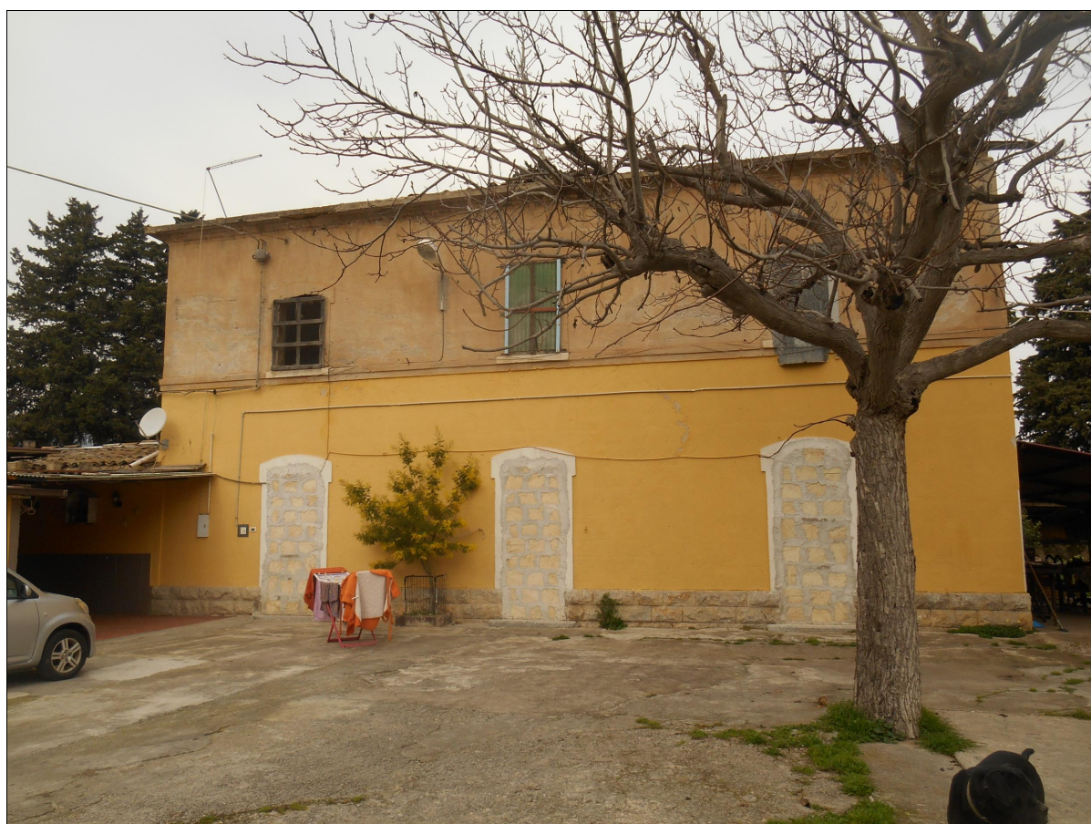
Stazione Uditore. Prospetto principale
