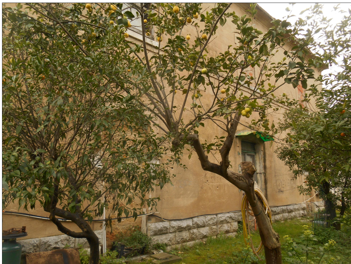
Stazione Uditore. Prospetto posteriore
